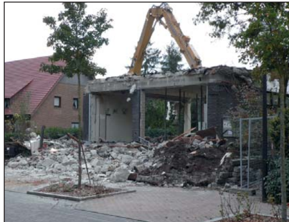
„Meine Bank“ im neuen Outfit wird es im kommenden Jahr an der Bahnhofstraße heißen, wenn die Volksbank Heiden eG ihr neues Bankgebäude beziehen wird. Die Arbeiten dazu laufen erfolgreich.
